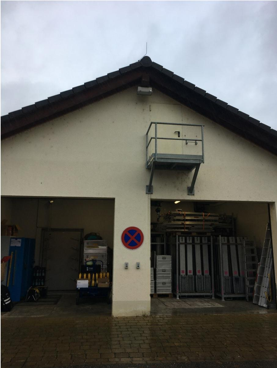
Es ist vorgesehen die bestehende Eingangstür in der Breite um das doppelte Maß zu erweitern sowie eine neue, den Anforderungen entsprechende Zugangsplattform anzubringen. Die Leistungen umfassen Mauer-, Verputz- und Stahlbauarbeiten einschließlich der statischen Nachweise. Ebenfalls sind Änderungsarbeiten an der Entlüftungsanlage und der Elektroinstallation erforderlich.
